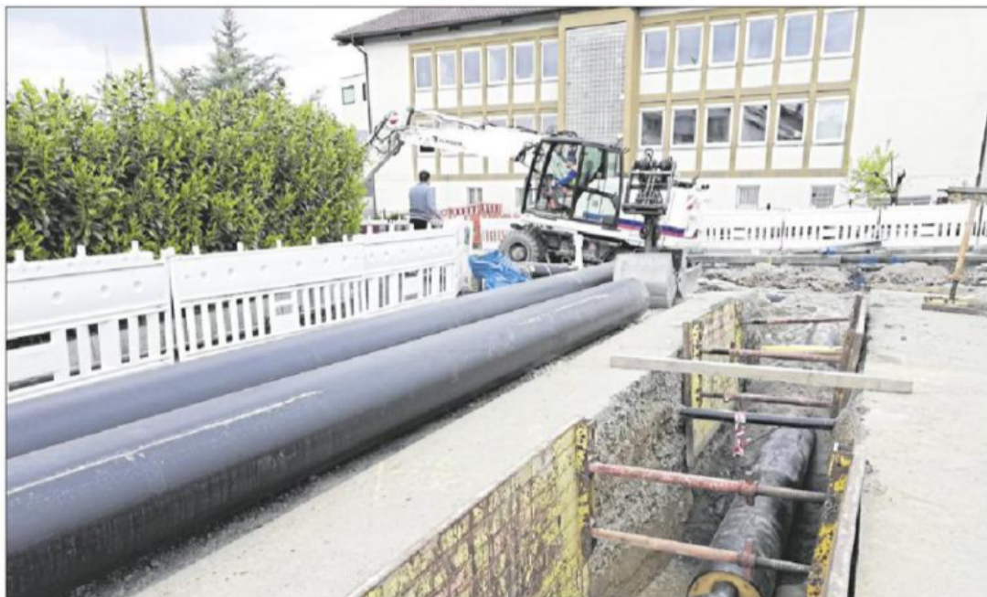
In der Aschmannstraße beim Technischen Rathaus liegen die Rohre für die Nahwärme bereits in der Erde.
